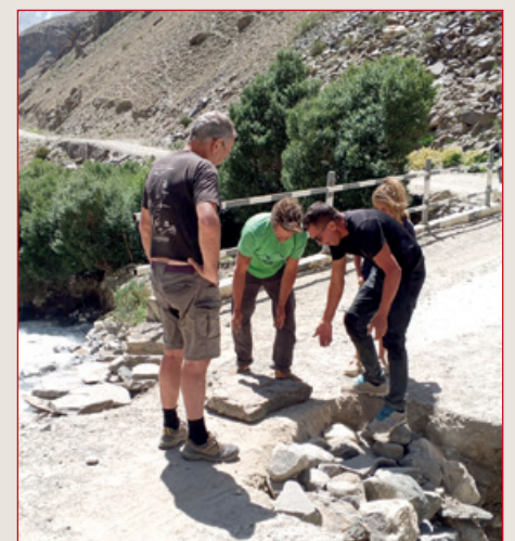
Brückenbefestigung am Pamir Highway
