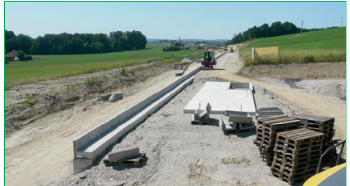
Grundfeste für die Haltestelle Diepoltsdorf
