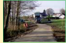
GEH- UND RADWEG ERNSTING Bauarbeiten begonnen
