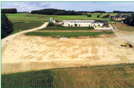
Hier entsteht der neue Bauhof
